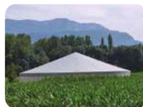
Marsens (Suisse) Fosse à lisier Ø32,5m Hauteur du mât 14m
